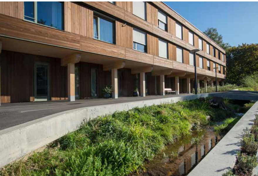
Die Stiftung Dominikushaus in Riehen hat ihren Neubau am 20. August 2023 eröffnet.
